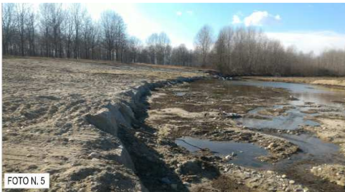
Fiaura 9. Lavori di sistemazione dell'alveo effettuati dal Comune di Chivasso
